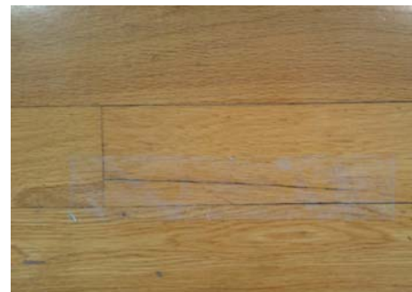
写真3 床板の割れをテープで補修
